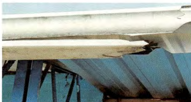
Foto 7: Sustitucion de canales PVC
