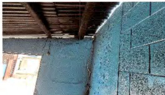
Foto 2: Sustitucion de estructura de madera por metal
