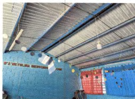
Foto 12: sustitucion de focos ahorradores
