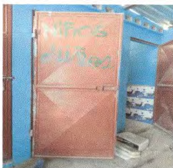
Foto 9: Mantenimiento a estructura lijado y cepillado y aplicación de pintura apuertas del servicio Sanitario
