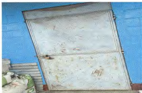
Foto 3: Mantenimiento a estructura cepillado y aplicación pintado de puerta
