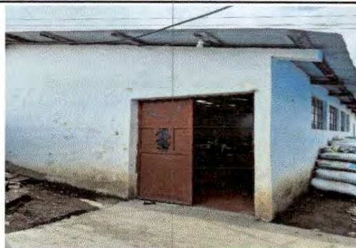
Foto 8: Pintura en Muros Exteriores e Interiores
