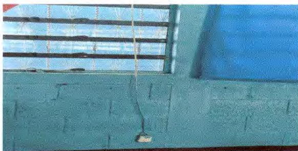
Foto 13: Sustitución del cableado eléctrico
