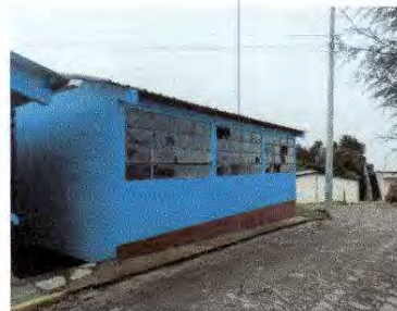
Foto 4: Sustitucion de vidrios
