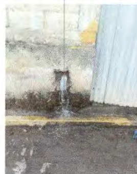
Foto 10: Sustitucion de tubería PVC aguas negras
