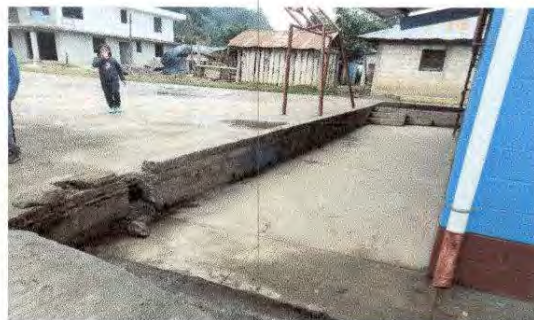
Foto 14: Aplicación de repello de muro de contención
